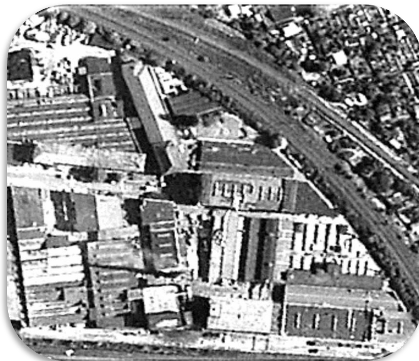
Luftbild von GTL Werk I 1980
